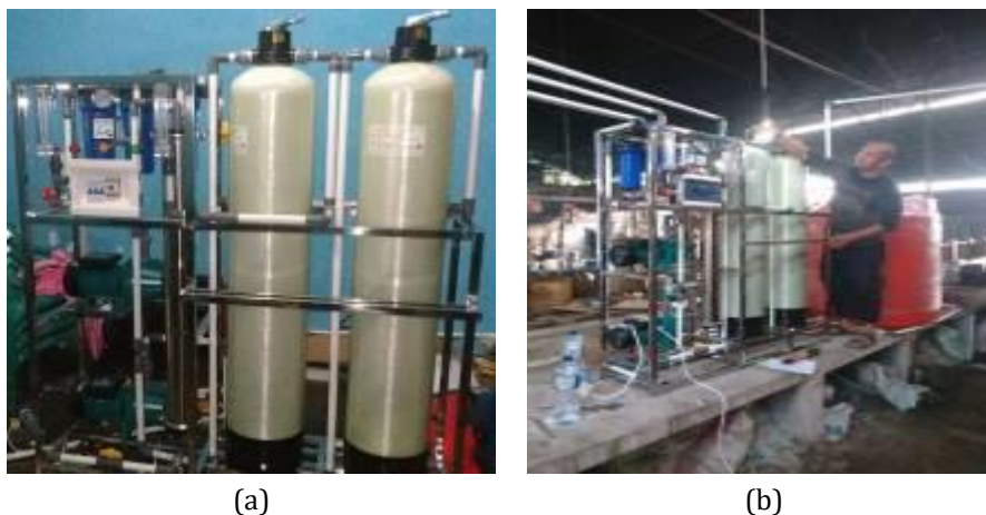
Gambar 3. Pemasangan Pengolahan Air di lokasi (a) sebelum dipasang, (b) setelah dipasang
