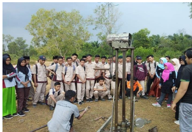
Gambar 3. Praktek Pengenalan Dasar Soil Investigasi Untuk Menentukan Jenis Pondasi yang Digunakan Berdasarkan Jenis Tanah
