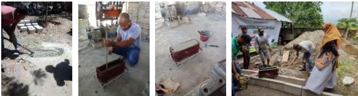
Gambar 2. Pembuatan castin dari pencampuran, pencetakan dan pengeringan
