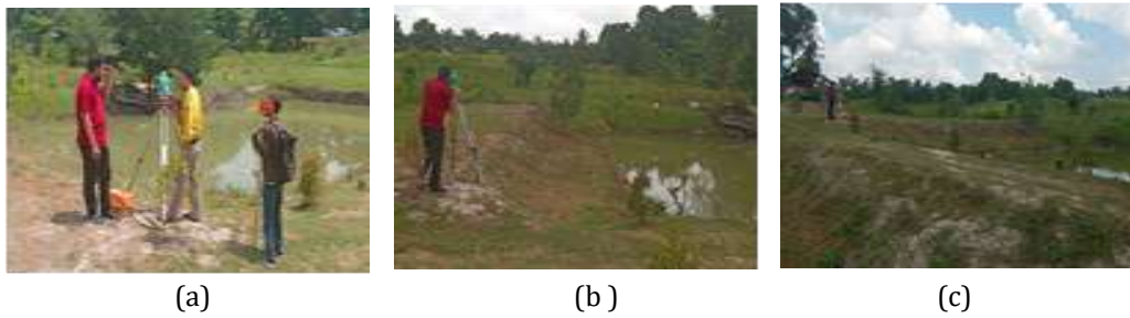
Gambar 7. (a,b,c) Pelaksanaan survey pengukuran dilapangan
